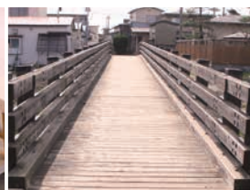
A②中川原/木の橋
