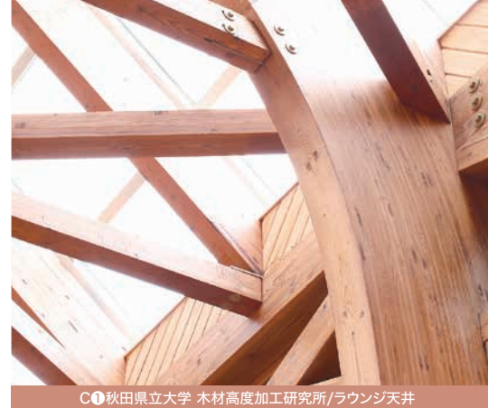
C①秋田県立大学 木材高度加工研究所/ラウンジ天井
